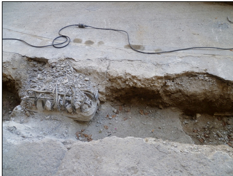
Fotografia 11. Detall Fonamentació i riosta UE103.
