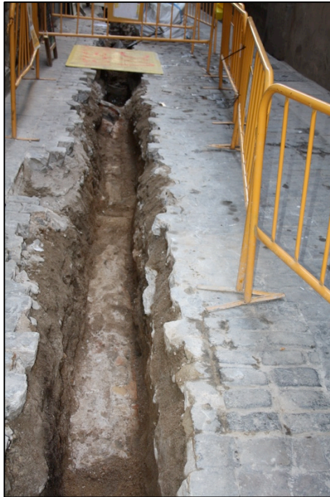
Fotografia 3. Vista Rasa 100 amb vista general claveguera UE105.
